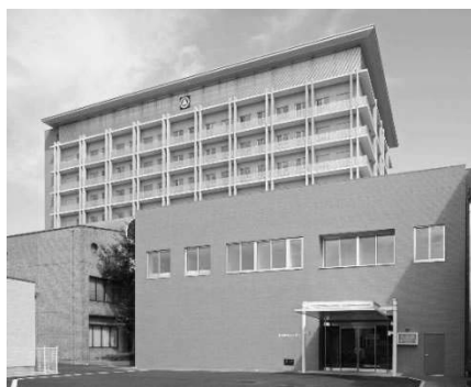
本館・救命救急センター
