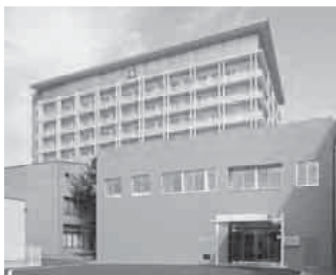
本館・救命救急センター
