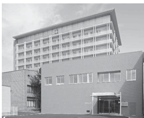
本館・救命救急センター
