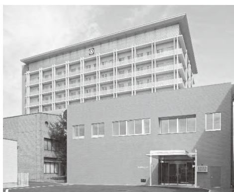
本館・救命救急センター
