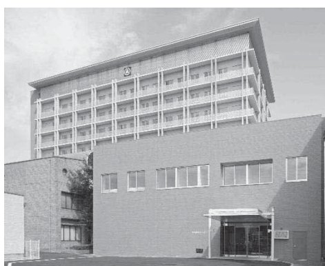
本館・救命救急センター
