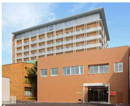
本館・救命救急センター
